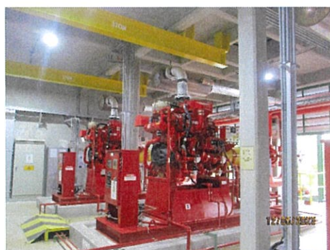
ภาพที่ 2-34 Fire Pump เป็น Vertical Pump บริเวณ Fire Pond
